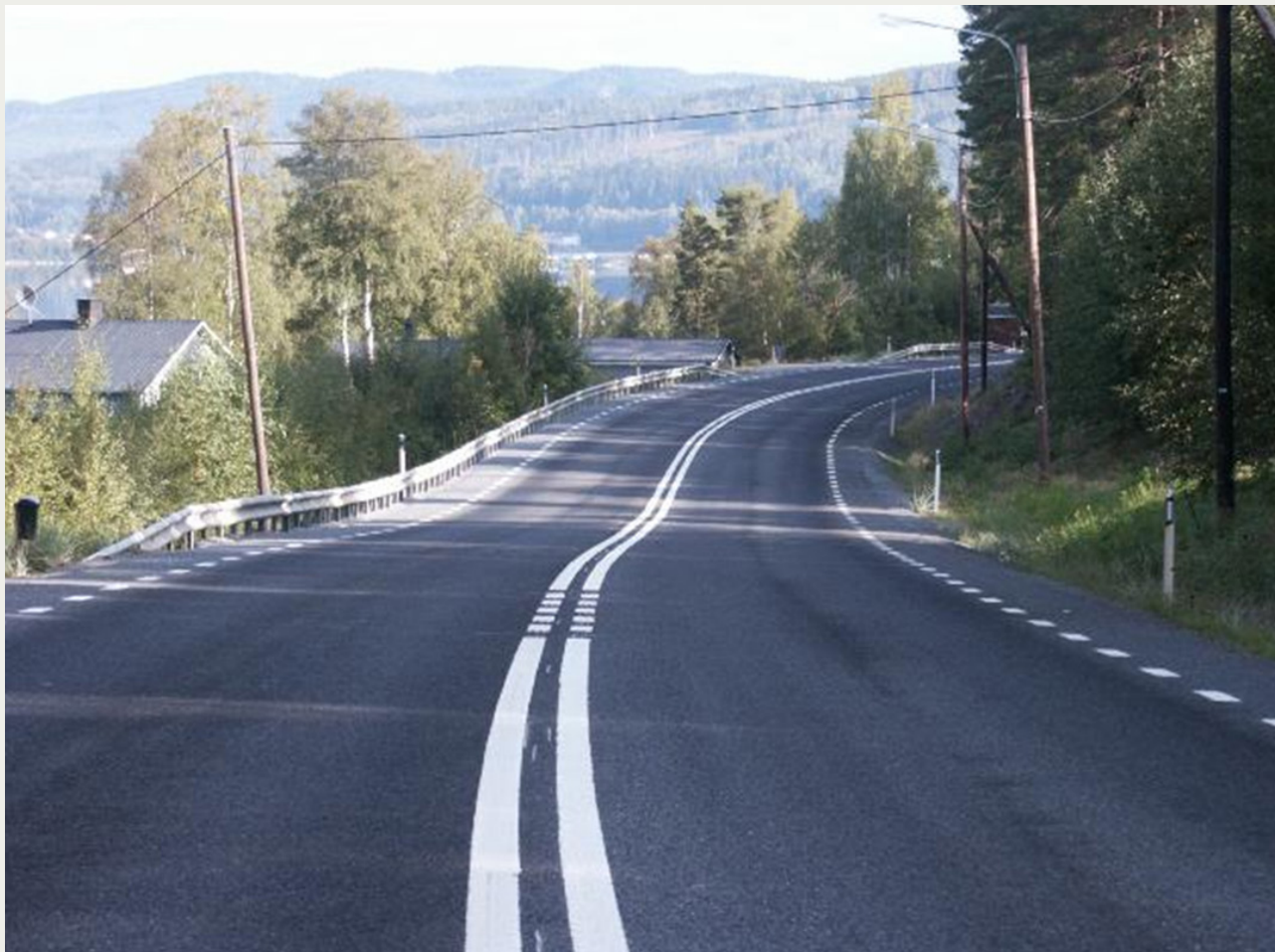
Exempel på öppning i dubbel heldragen mittlinje: två ledlinjer.
